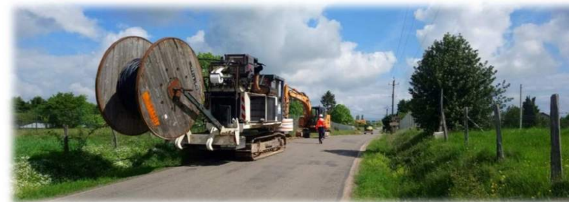
Exemple de chantier d'enfouissement de câble le long d'une voirie (source : sciepd)
